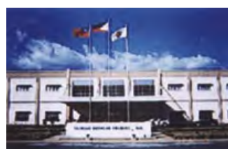
Hitachi Air Conditioning, Филиппины
